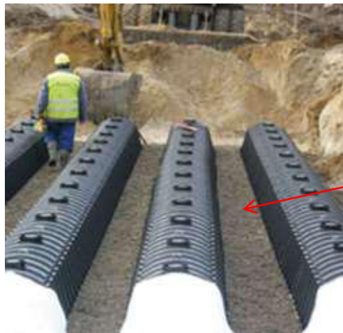
Exemple de mise en place de Tunnels d'infiltration
