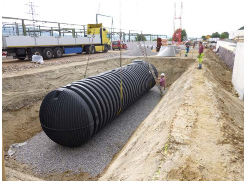
Exemple de mise en place de cuve carat XXL
